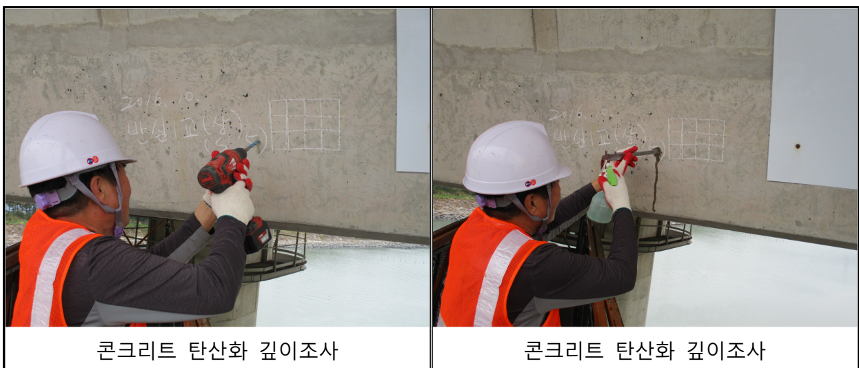
<사진 4.6>콘크리트 탄산화 깊이조사
