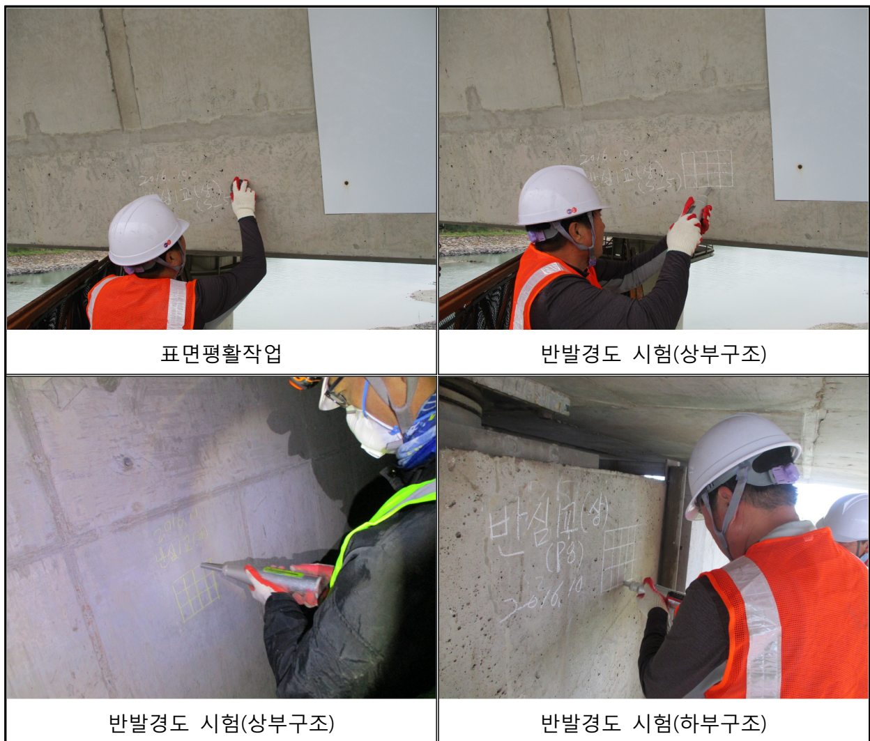
<사진 4.1>반발경도 시험 사진
