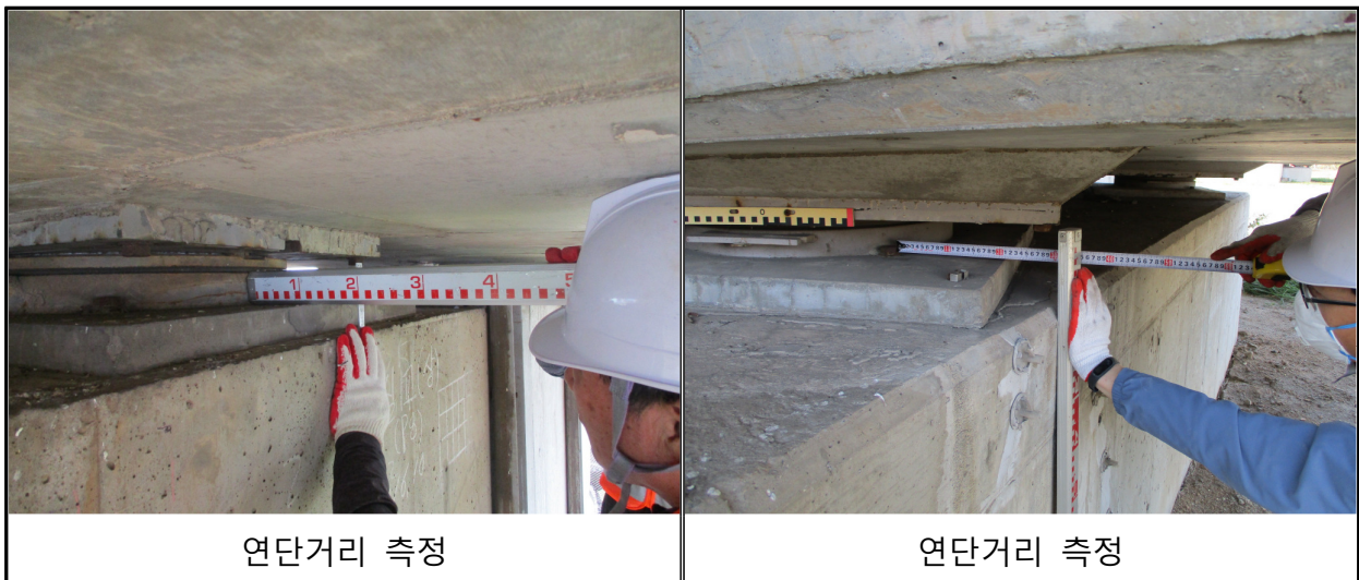
<사진 3.9>연단거리 측정
