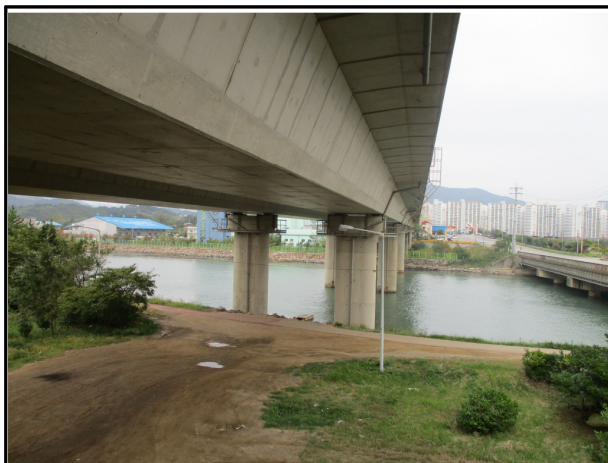
PSC Box 외부 전경
