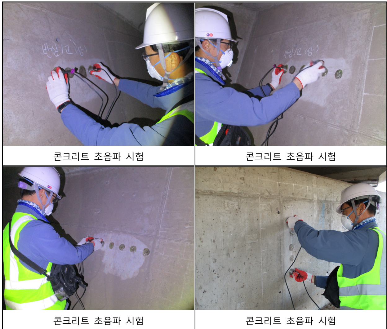
<사진 4.2>콘크리트 초음파 시험 사진
