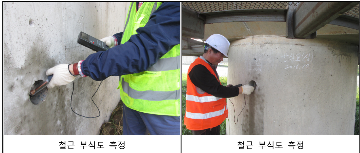
&lt;사진 4.5&gt;철근 부식도 측정 사진
