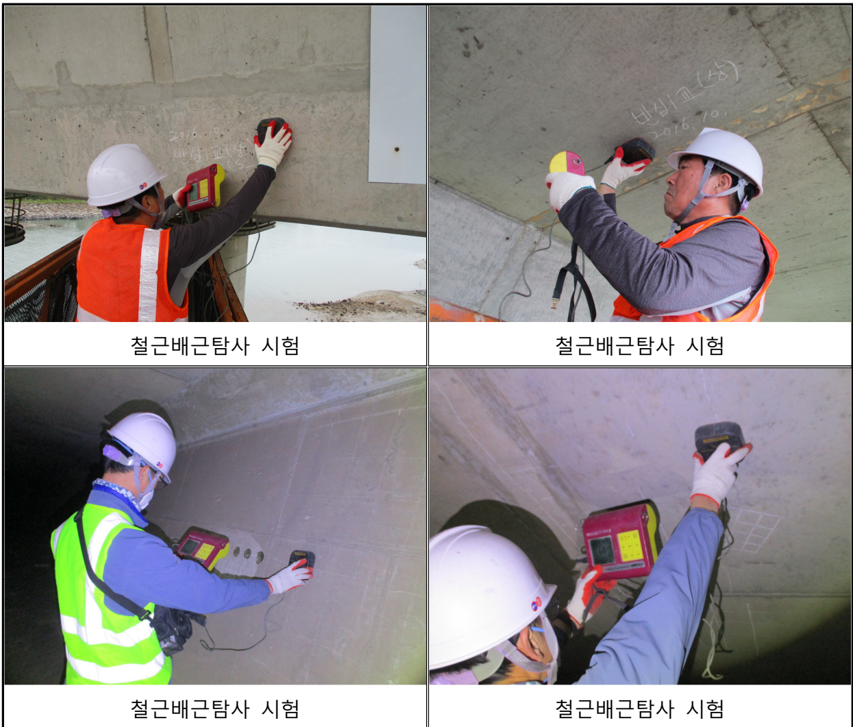
<사진 4.4> 철근배근탐사 시험 사진
